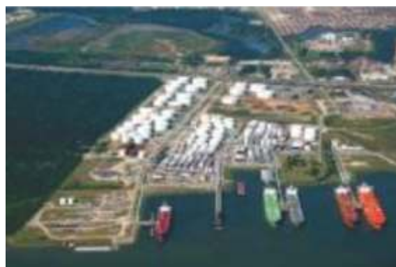
Terminais de Abastecimento
